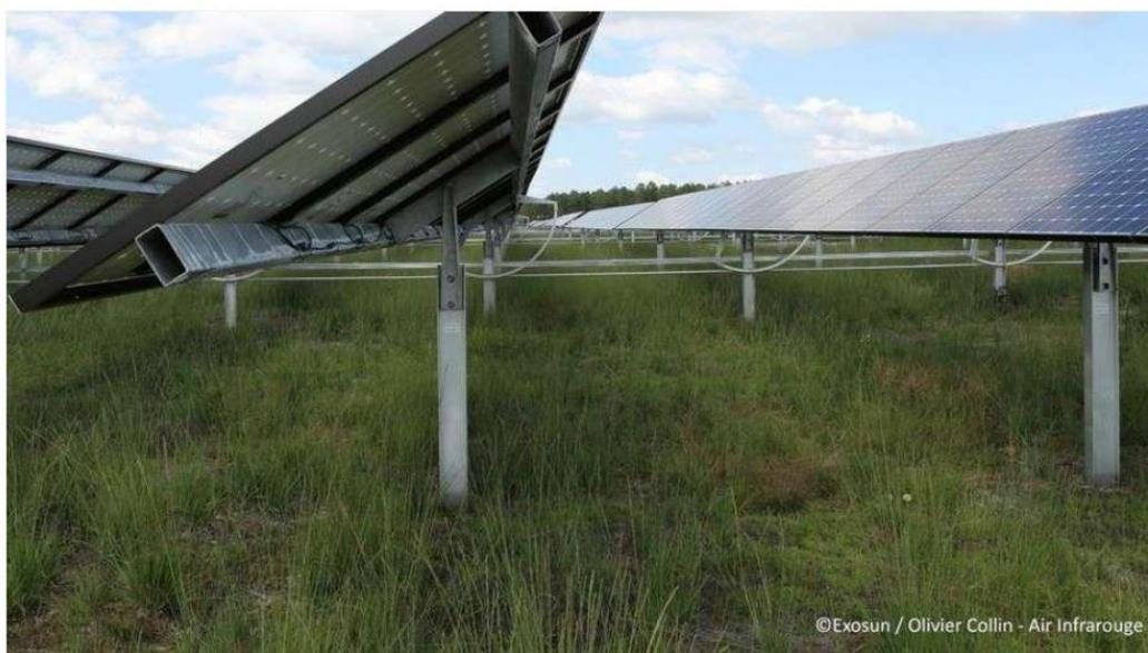
Exemple de suiveur mono-axial (Source : Exosun)
